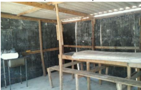
Foto 39: instalações para uso dos operários da construção
