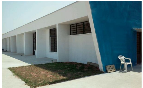
Foto 38: fachada lateral da creche
