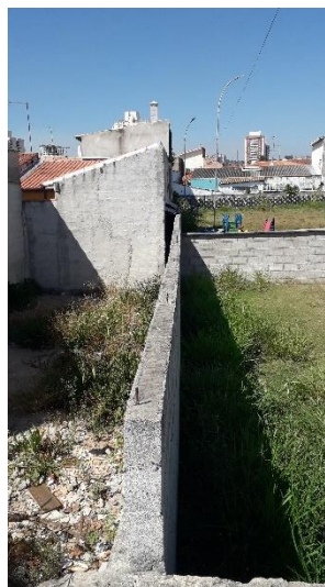
Muro divisa terreno/creche – lado direito
